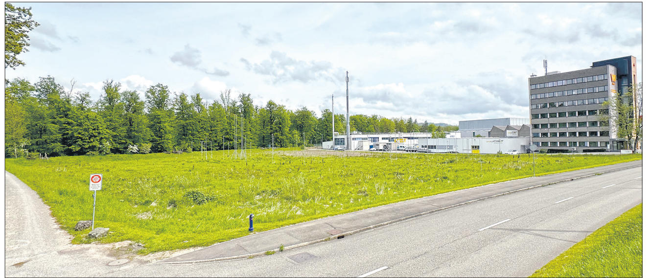
Hier bei den Bauprofilen im Wildschachen kommt die Wasserstoffproduktionsanlage Wildeggen-Brugg der Axpo hin. Nach den Einwendungen seien verschiedene Massnahmen für die Reduktion von Lärmmissionen in die Planung aufgenommen worden, versichert Axpo-Sprecher Stephan Weber.
