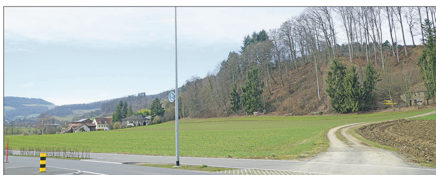
Bis 2013 war das Kabel der Telefonzentrale noch in Betrieb – erst danach war die Anlage im Hügel Balmhölzli, hier von der Badi Villnachern aus gesehen, nicht mehr klassifiziert.
