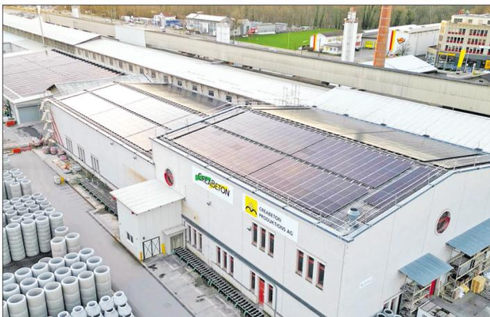
Die PV-Anlage mit einer Leistung von 683 kWp erstreckt sich über eine Fläche von 3'142 Quadratmetern und produziert jährlich rund 680'000 kWh Strom, was dem Stromverbrauch von rund 150 Haushalten entspricht. Durch die Nutzung von Solarenergie kann die Creabeton Produktions AG ihren CO<sub>2</sub>-Ausstoss um etwa 87 Tonnen pro Jahr reduzieren.
